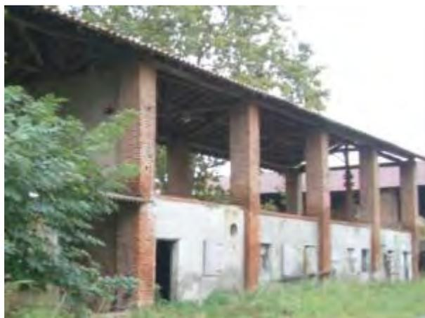
*Rustico (in passato adibito a stalla) di una cascina nei pressi di Cascinazza: mattoni a vista, tinteggiatura della parete della stalla, le travi lignee a sostegno della copertura*
